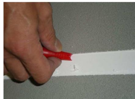
1- Le joint de bordurage doit être appliqué dès que possible après la pose du revêtement anti-dérapant TBS afin d'éviter que les saletés et les poussières ne contaminent le bord du revêtement .
